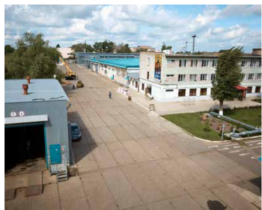
Производственная база перед реконструкцией
