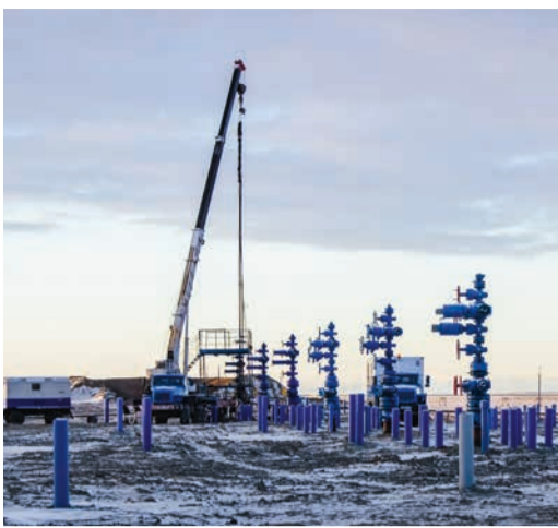
На скважине Бованенковского нефтегазоконденсатного месторождения
