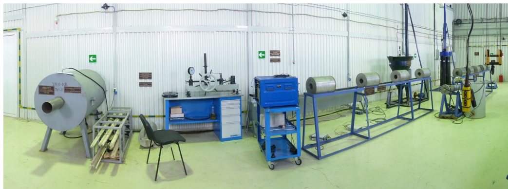
Центр ремонта геофизической аппаратуры на Бованенковском НГКМ
